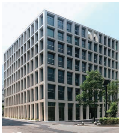
新「全国信用組合会館」2019年7月31日竣工
