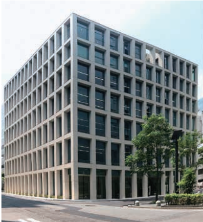
新「全国信用組合会館」2019年7月31日竣工
